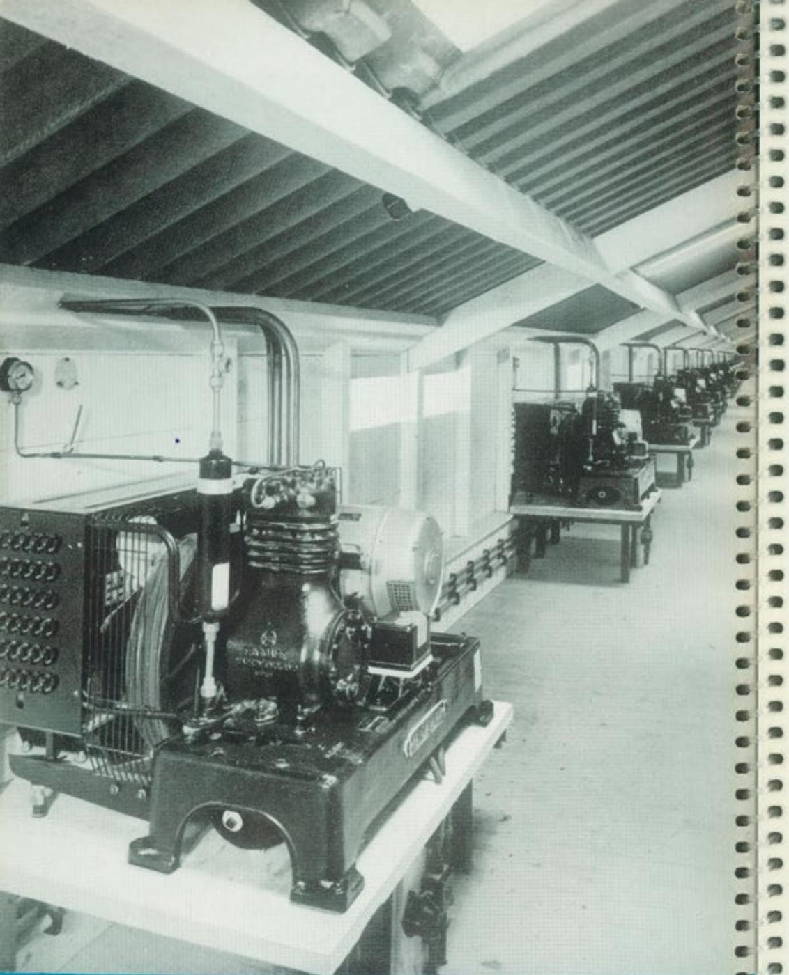
Un autre aspect de l'installation frigorifique : une des batteries de compresseurs assurant le conditionnement de l'air par température trop élevée dans les chambres de stockage.
